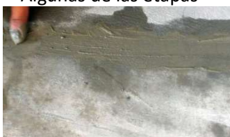
Rellenando con Microcreto ®
